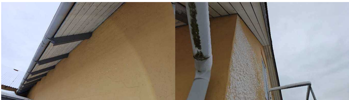
Figur 22: Tagudhæng (venstre) fremstår med smalle mellemrum. Samme konstruktion ses ved gavlen (højre).
