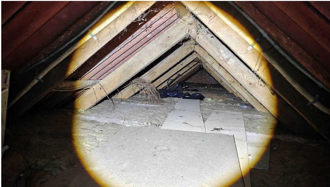
Figur 23: Loftrum for Bygning 9.
