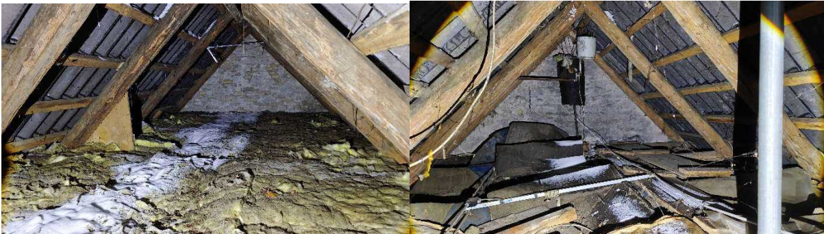
Figur 13: Loftrum i bygning 4.
