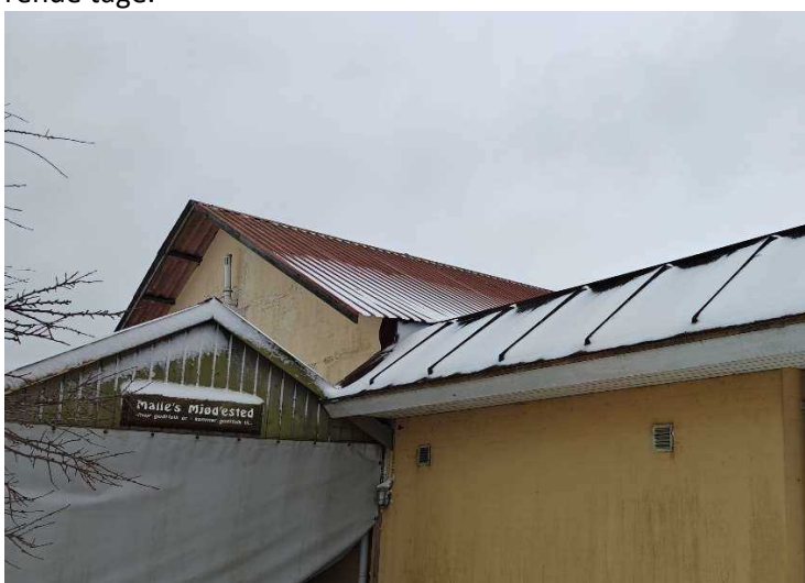
Figur 18: Tagkonstruktion for Bygning 8 ses i baggrunden (rødt pladetag).
