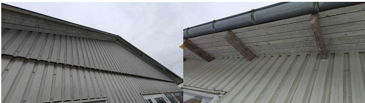
Figur 6: Gavle (venstre) fremstår tæt. Under tagrenden (højre) findes smalt mellemrum i tagudhænget.
