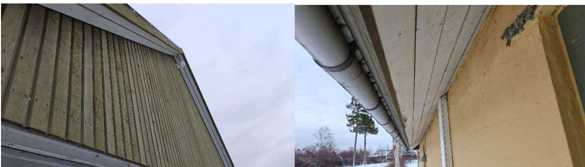
Figur 3: Tagudhæng i gavl samt langs bygningens side.
