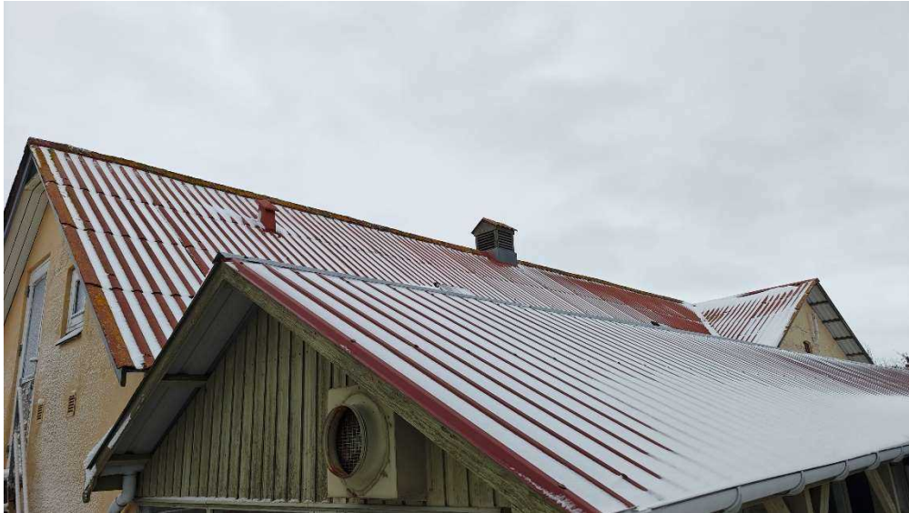
Figur 21: Bygning 9 (venstre side, med gule vægge) i baggrunden ses gavl for bygning 8.
