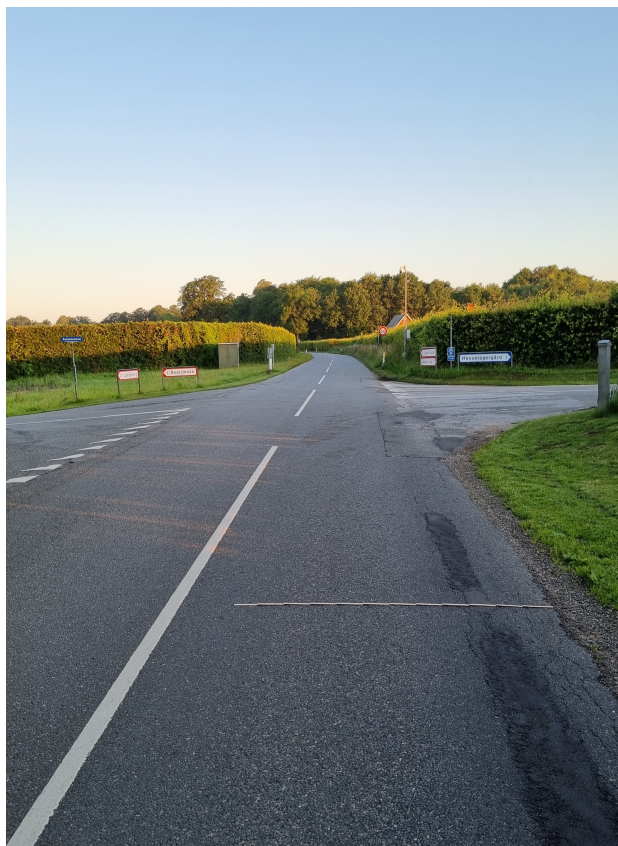
Stenmurevej, vejbredde 5,20 m
