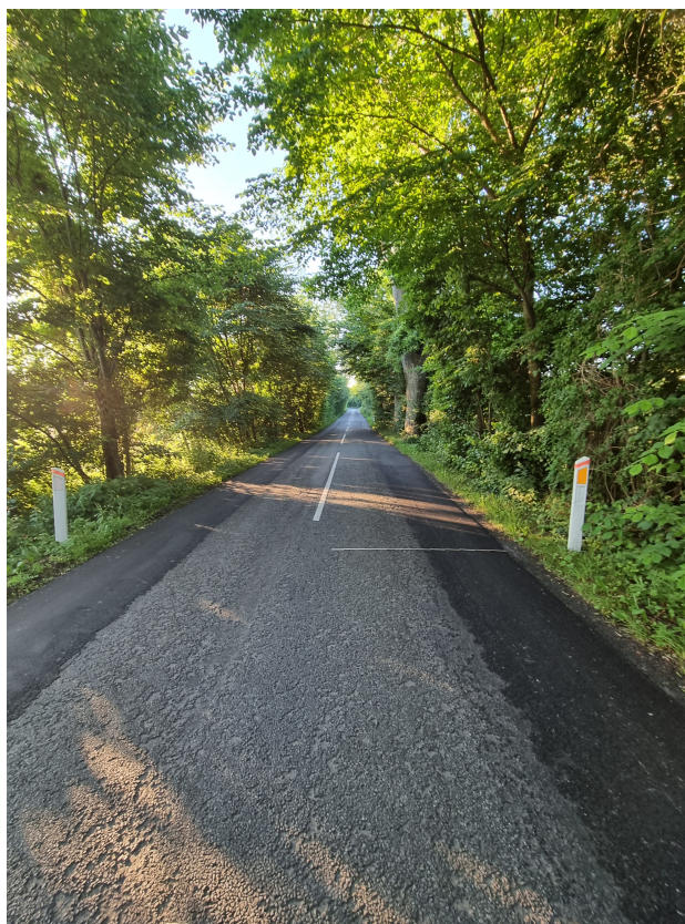
Stenmurevej, vejbredde 4,85 m
