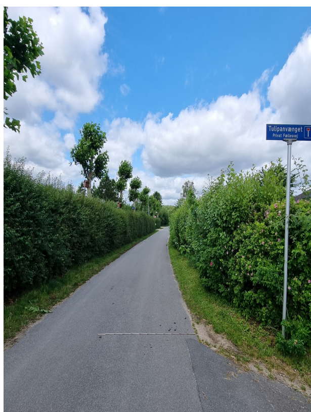
Gl. Lundebergvej ved Tulipanvænget, vejbredde 3,70 m
