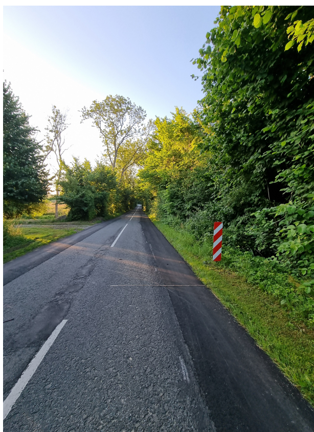
Stenmurevej, vejbredde 5,10 m
